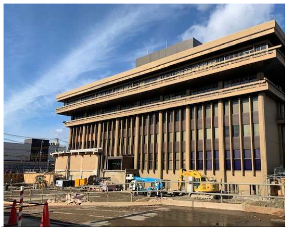
現庁舎南側に新庁舎建設が始まりました。重厚感ある現在の庁舎が取り壊されることは勿体なく、残念に感じます。
